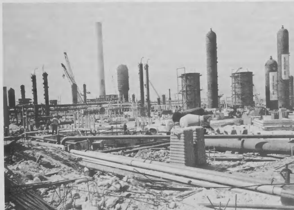
Many of the HDS units are taking shape, changing the refinery skyline. Hopi di a unidannan HDS ta tumando forma, cambiando e aspecto di refinaria.
